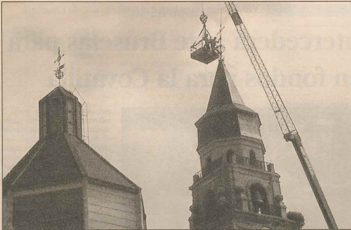
Los operarios trabajaron en condiciones difíciles, ante la mirada de cientos de peñarandinos.
